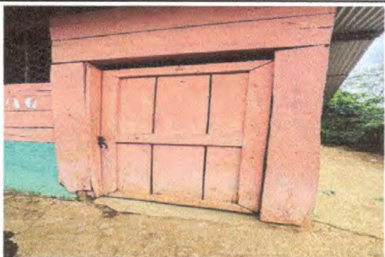
Foto 3: Sustitución de puerta
