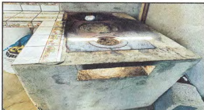
Foto 7: Sustitucion de Estufa rural incluye chimenea y plancha de metal
