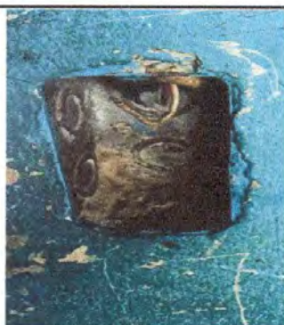
Foto 3: Sustitución de Apagadores
