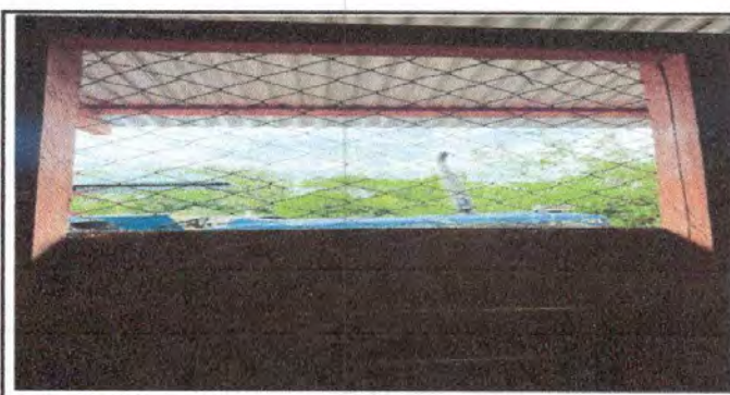
Foto 6: sustitucion de ventana
