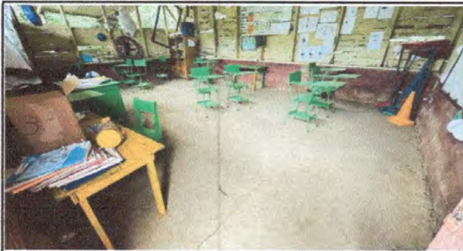
Foto 4: Reparación de piso de torta de concreto
