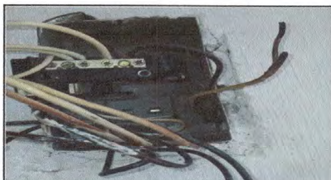
Foto 8: Sustitucion de Cableado Electrico en todo el establecimiento
